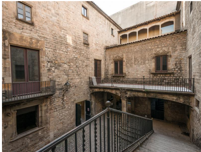
Vista del palau dels Marquesos de Llió situat al carrer Montcada de la ciutat de Barcelona 124
