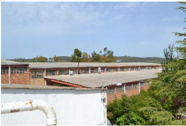
Vista de la fabrica en direcció nord-est.
