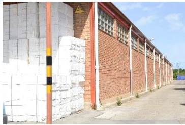
Imatge longitudinal de la nau principal amb materia primera.
