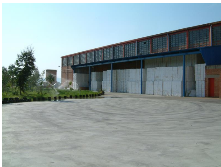
Vista actual de la part nord de l'actual fàbrica.
